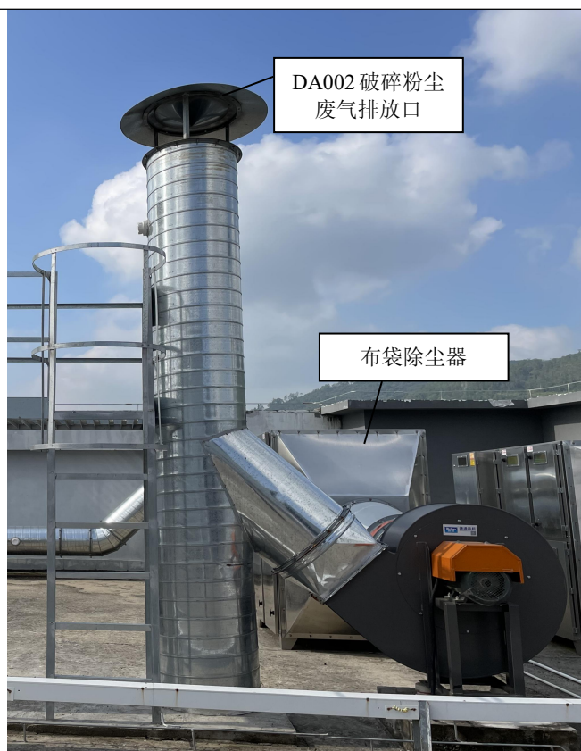
破碎粉尘废气处理设施及排气筒
