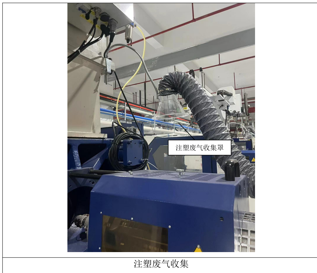
图 14 注塑废气收集设施现场照片
