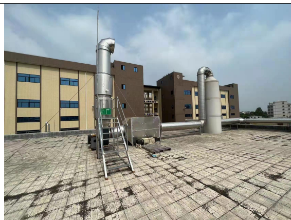
(甲类)旋流喷淋塔+活性炭吸附废气处理设施
