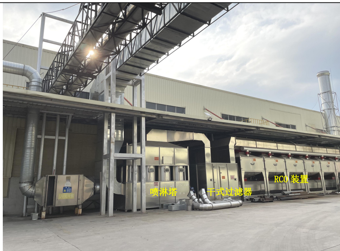
有机废气污染防治设施（喷淋塔+干式过滤器+RCO 装置）
