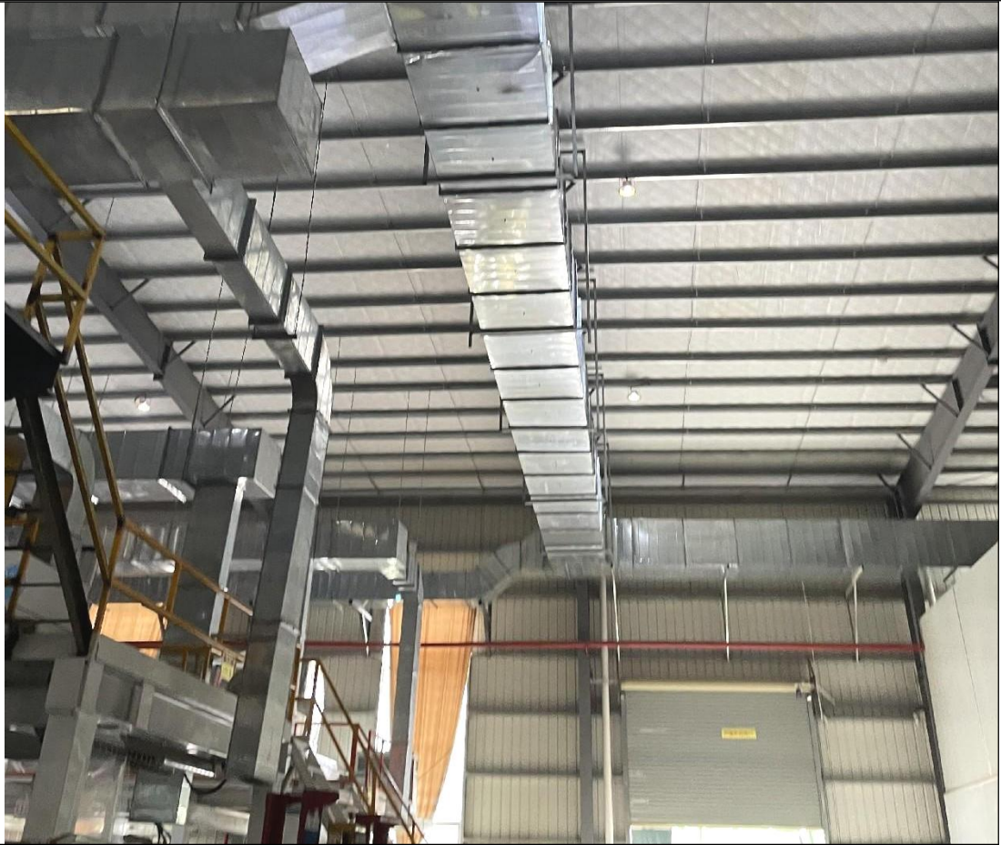
有机废气收集管道
