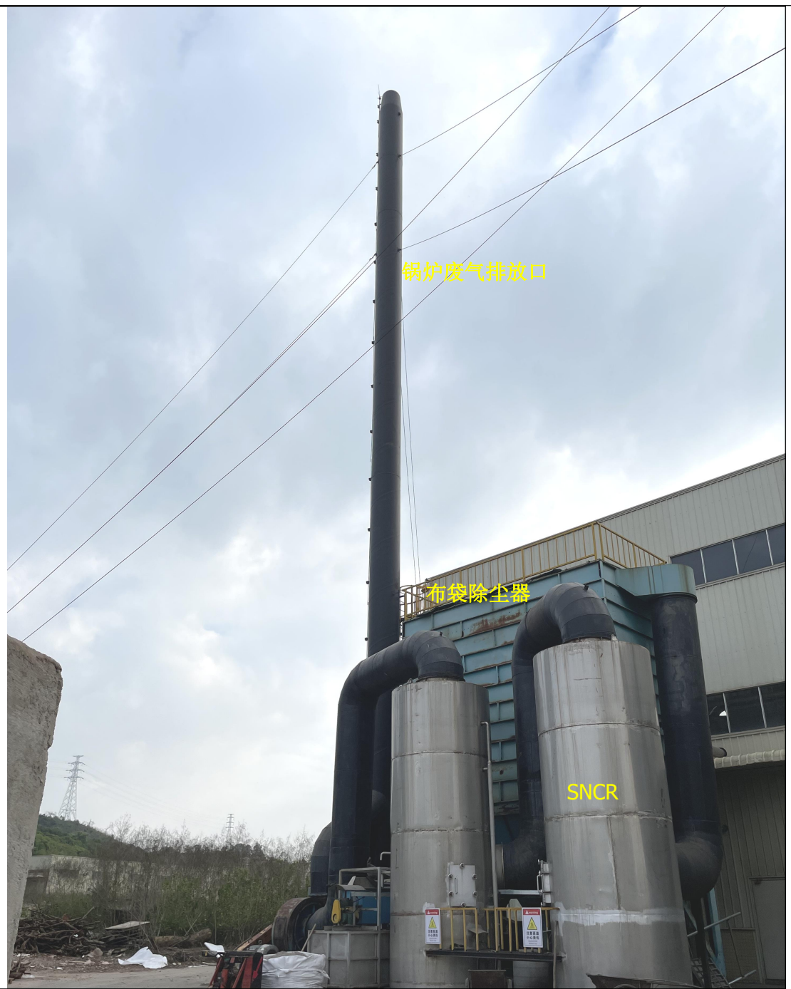
锅炉废气污染防治设施（布袋除尘器+SNCR）
