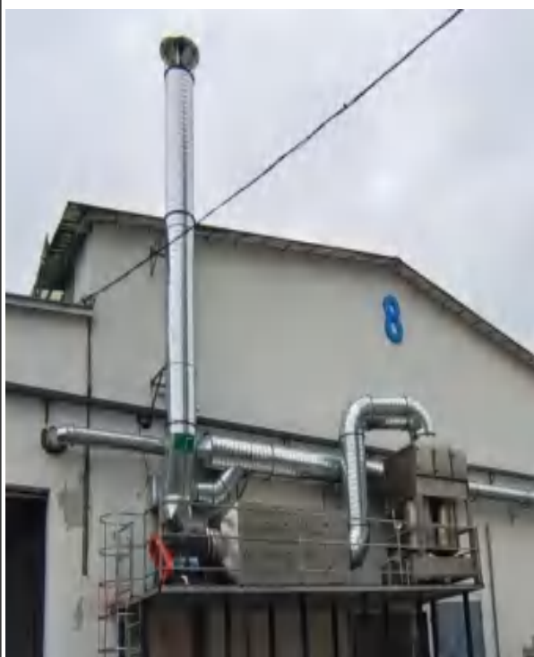
“喷淋塔+活性炭吸附+干式过滤器”废气处理设施
